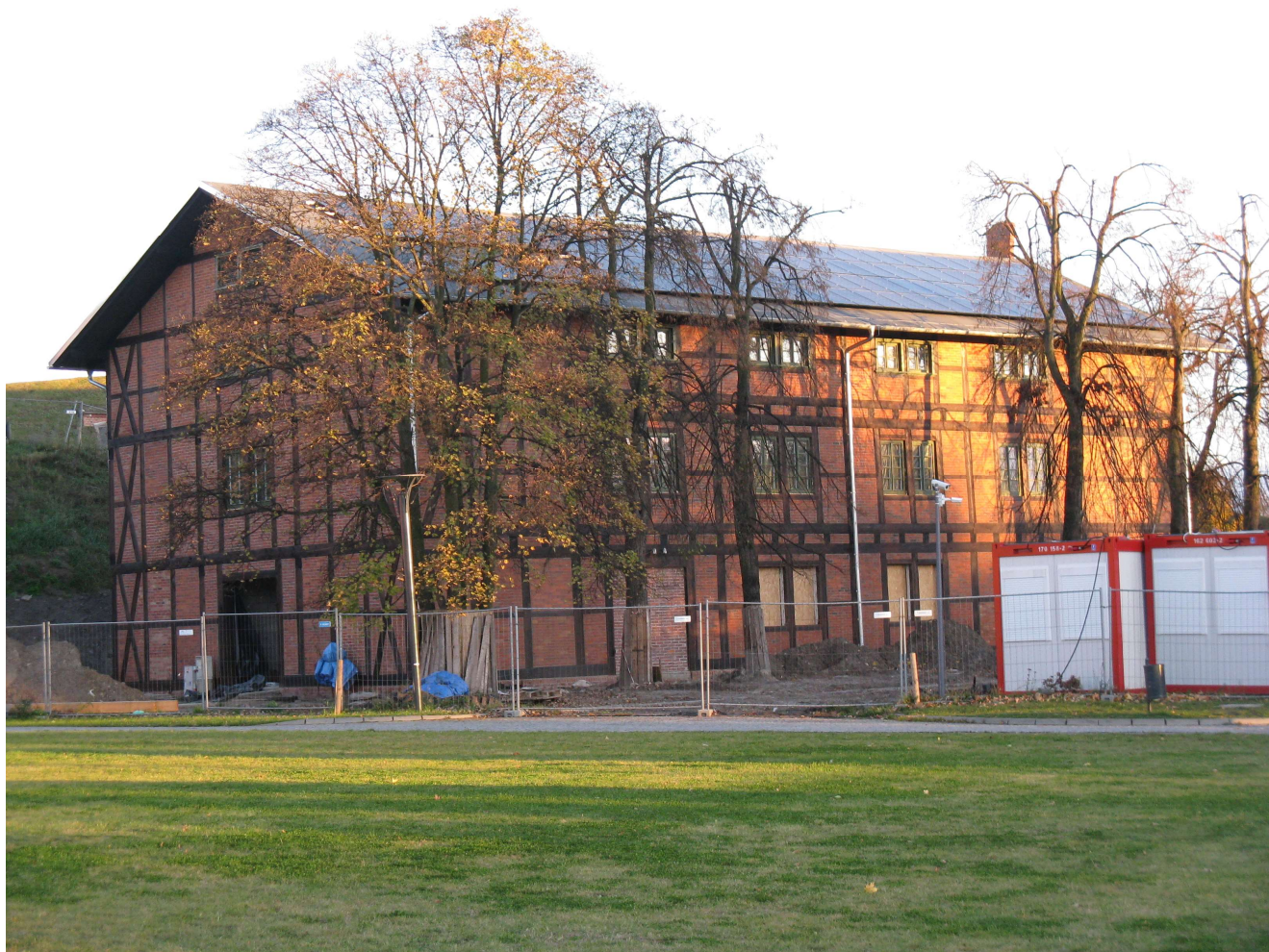
WOZOWNIA ARTYLERYJSKA - WIDOK OGÓLNY (W TRAKCIE ROBÓT BUDOWLANYCH)
